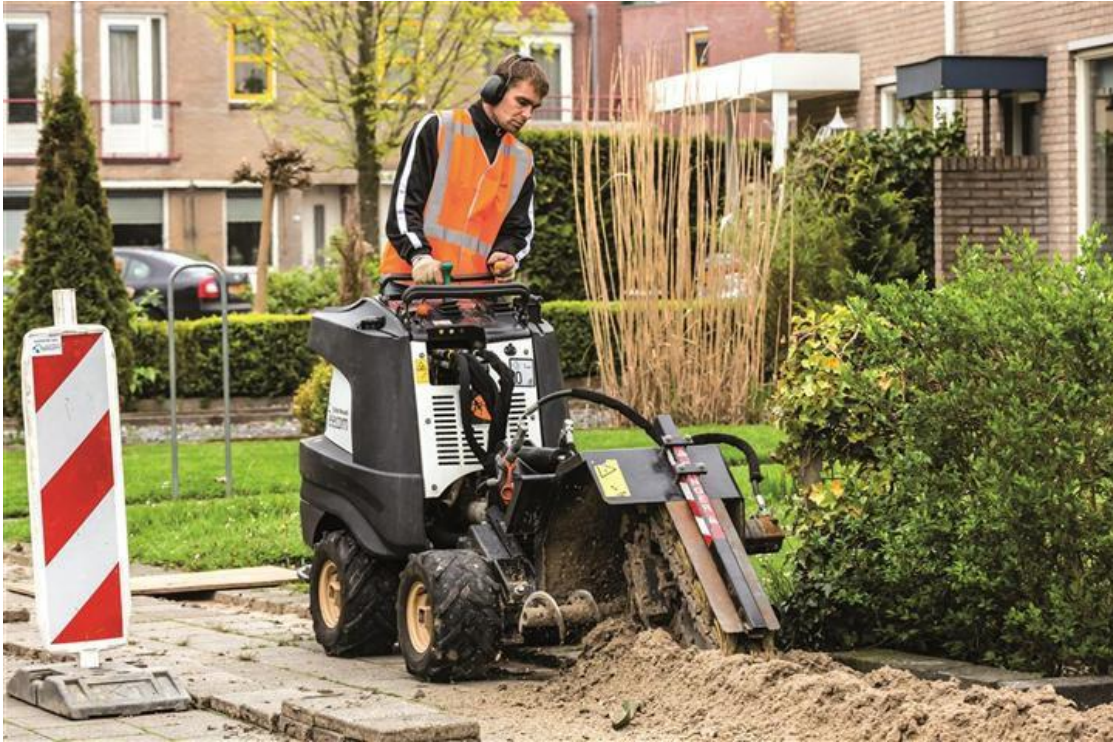
Figuur 9. Borstelen van een kabelgeul in een woonwijk
