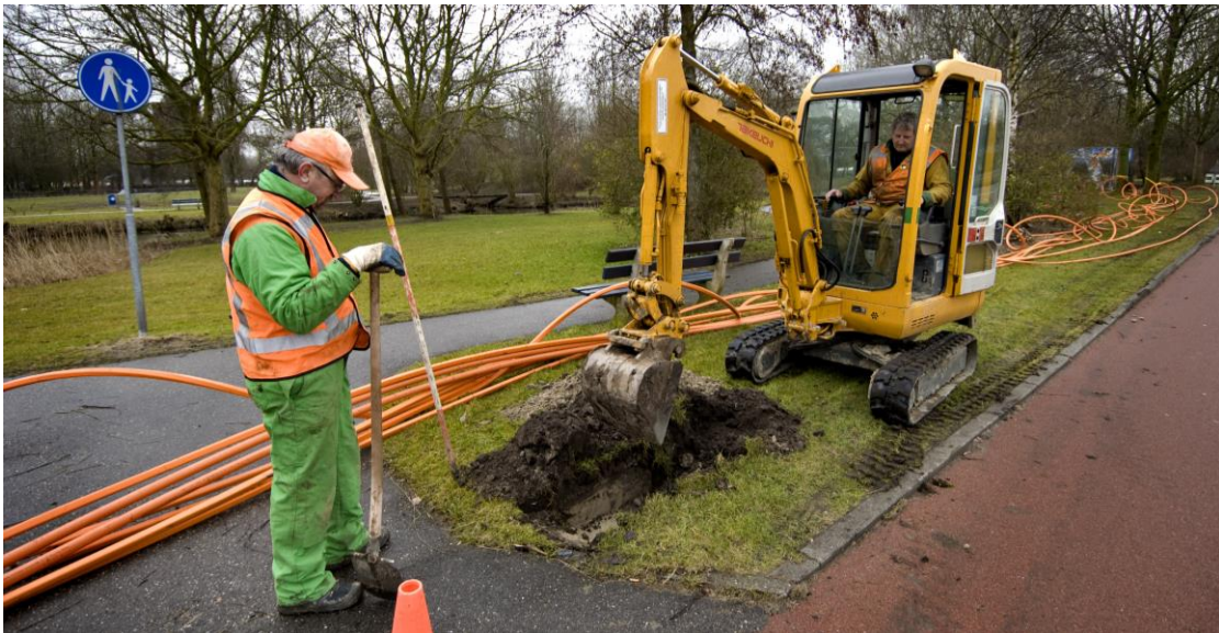
Figuur 6. Civiele werkzaamheden bij de realisatie van een glasvezelnetwerk in Empel
