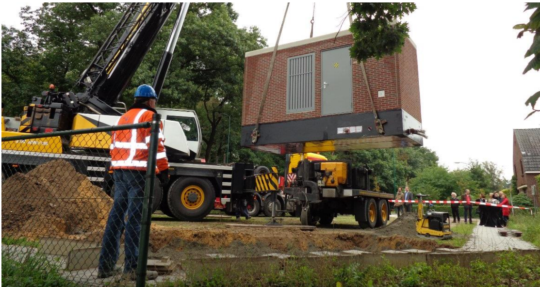
Figuur 10. Plaatsing van een HSLnet-PoP in Sterksel
