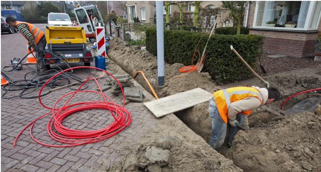
Figuur 7. De aanleg van glasvezel in de voortuinen van de eindgebruikers.
