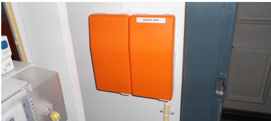
Figuur 8. Voorbeeld van afgemonteerde glasvezelaansluiting in de meterkast
