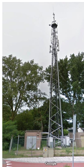
Figuur 23 Een vakwerkmast aan de rand van in Rosmalen (Empelseweg) (foto: Google)
